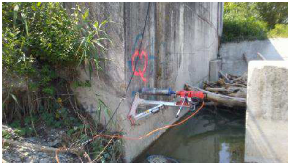
Foto 29. Traversa di Monte. Esecuzione carotaggi spalla destra
