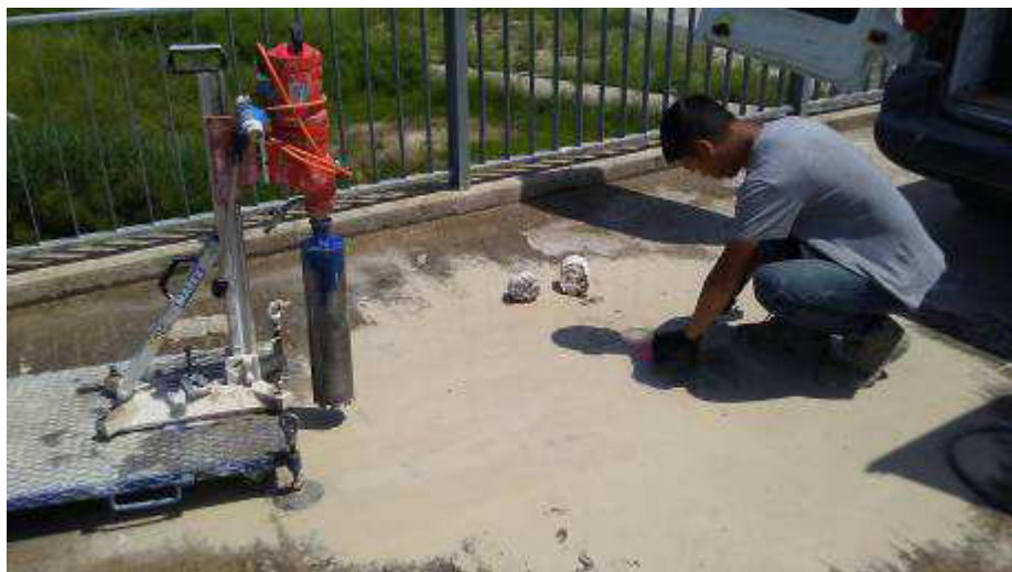
Foto 32. Manufatto limitatore di Monte. Esecuzione carotaggi sull'impalcato
