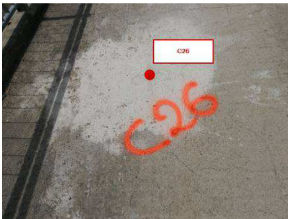
Foto 16. Manufatto limitatore di Monte. Evidenziati in rosso i prelievi delle carote
