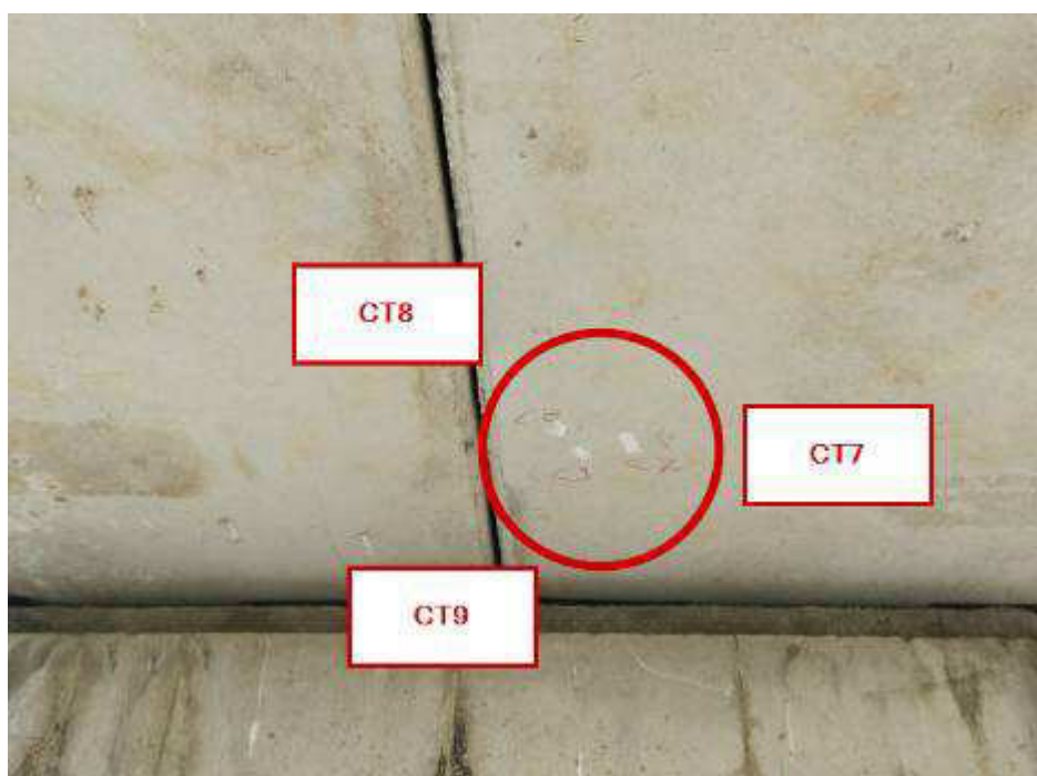
Foto 48. Manufatto limitatore di Monte. Manufatto in Alveo. Trave C.A.P. con evidenziati in rosso i punti di prova. Fase di chiusura dei fori
