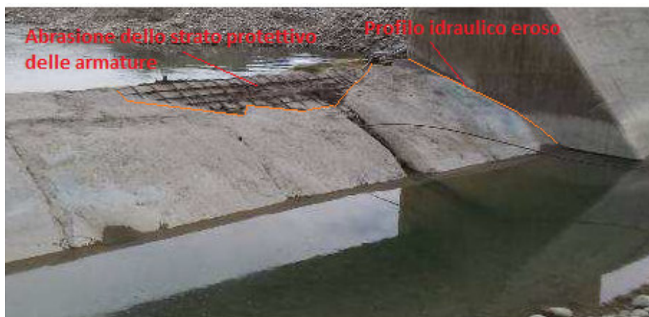
Fig.5.2 – Manufatto limitatode di monte : Vasca - Abrasione in Alveo
