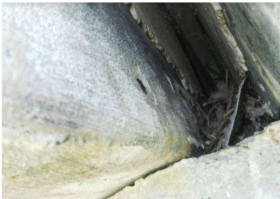
Foto 50. Manufatto limitatore di Monte. Sfiore di ingresso cassa. Appoggio trave C.A.P. su pilastro
