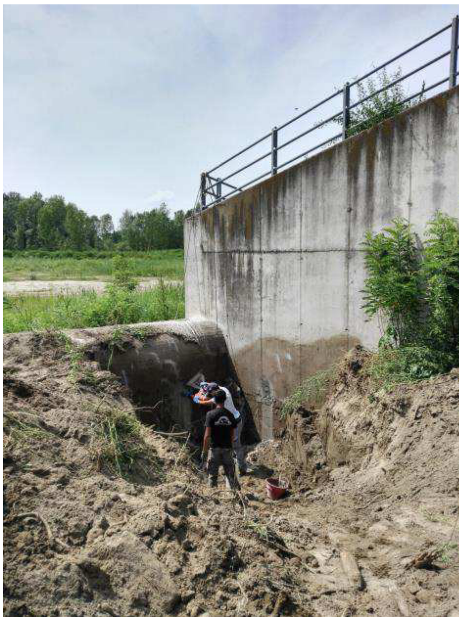
Foto 57. Manufatto limitatore di monte. Sfiore di troppo pieno. Saggio in fondazione
