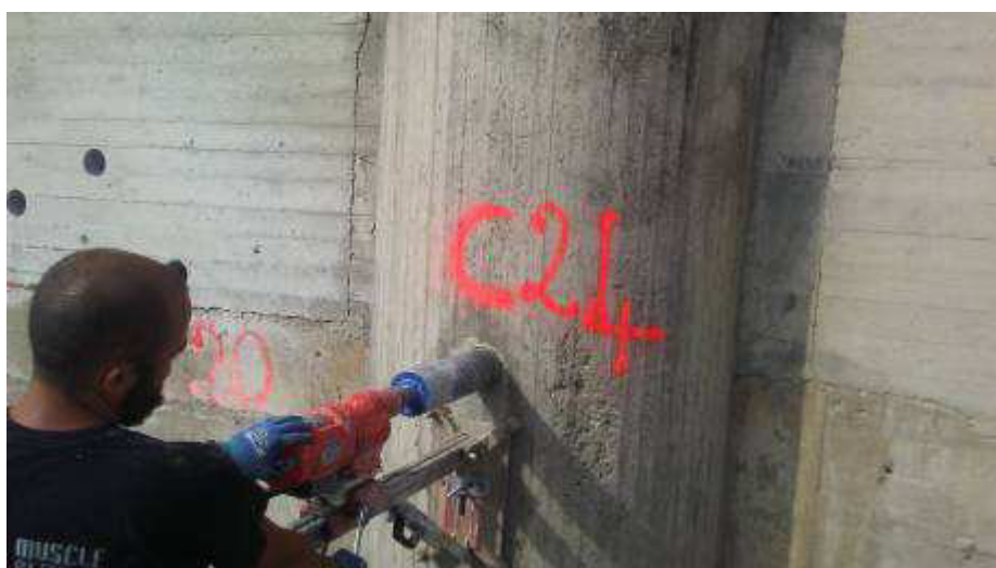
Foto 33. Manufatto limitatore di Monte. Esecuzione carotaggi su pile
