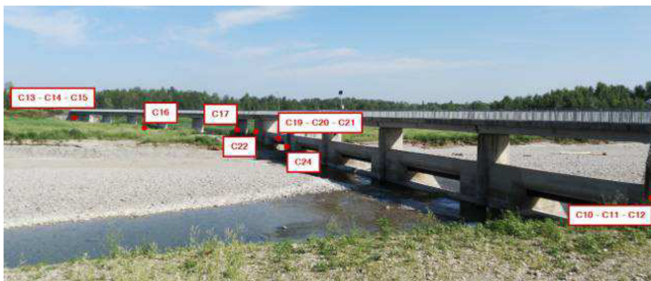
Foto 14. Manufatto limitatore di Monte. Evidenziati in rosso i prelievi delle carote
