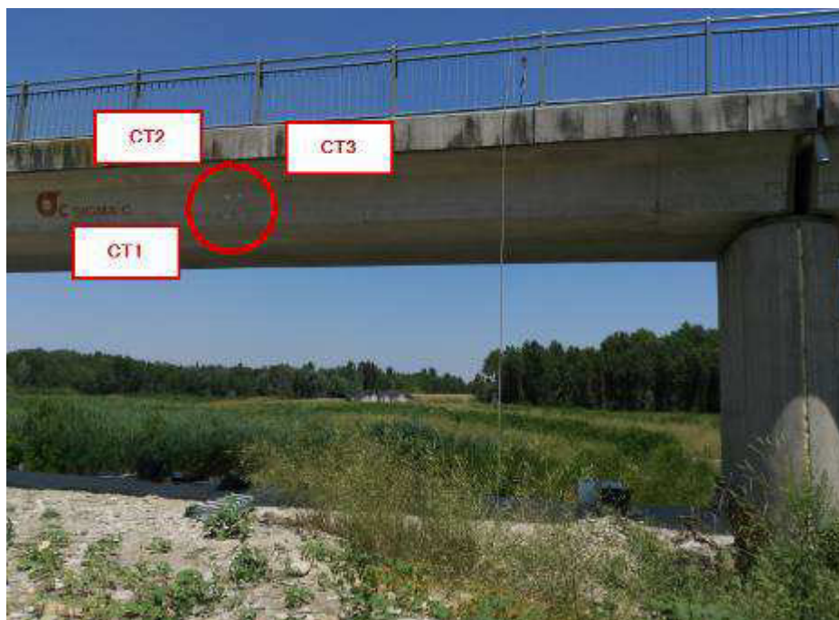
Foto 44. Manufatto limitatore di Monte. Sfioro di ingresso cassa. Trave C.A.P. con evidenziati in rosso i punti di prova.
