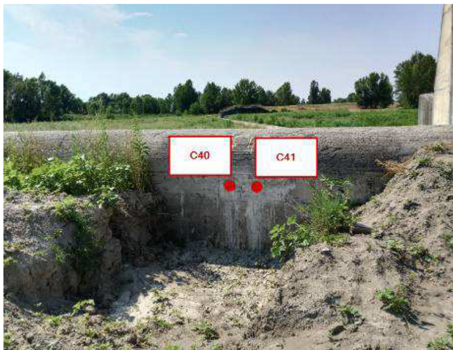
Foto 22. Manufatto limitatore di Valle. Evidenziati in rosso i prelievi delle carote
