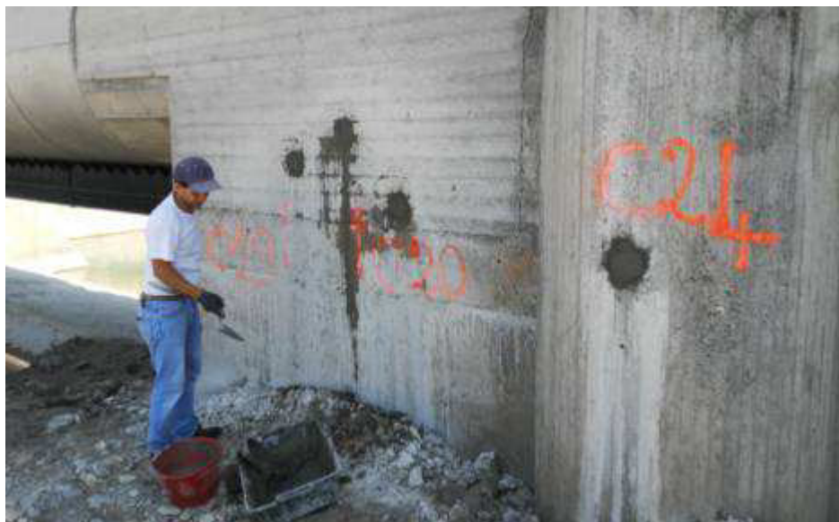
Foto 34. Manufatto limitatore di Monte. Fase di ripristino fori
