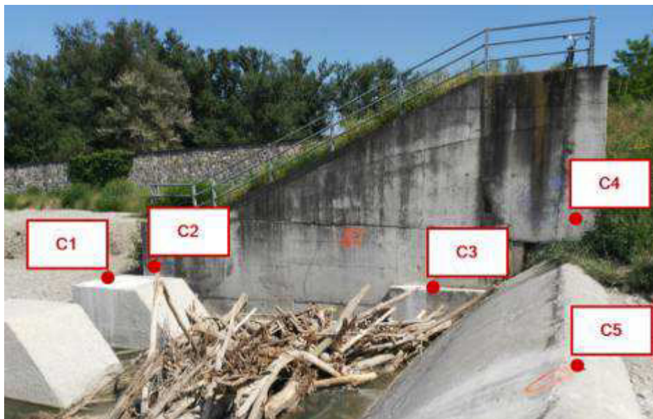
Foto 10. Traversa di Monte. Evidenziati in rosso i prelievi delle carote
