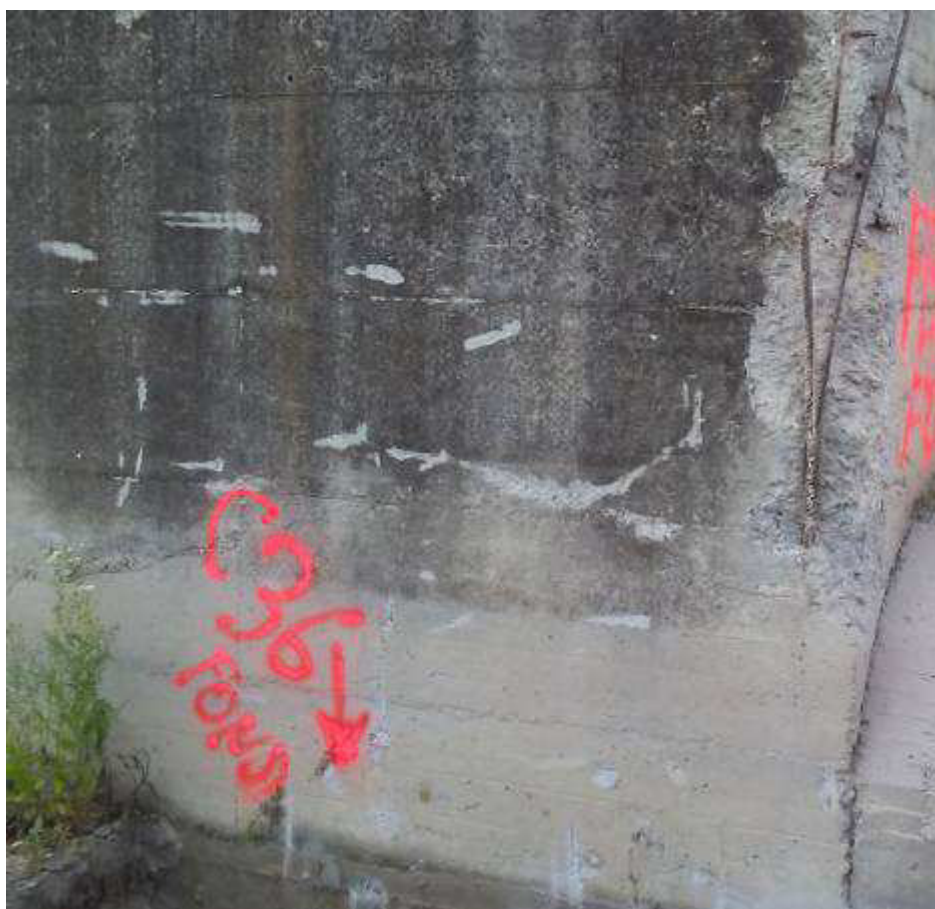
Foto 41. Prelievo ferri esposti. Manufatto limitatore di Valle
