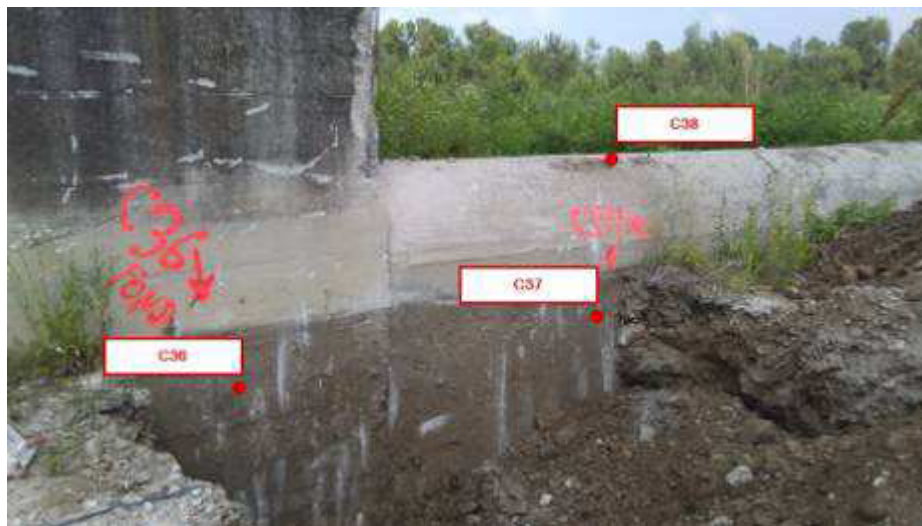
Foto 26. Manufatto limitatore di Valle. Evidenziati in rosso i prelievi delle carote
