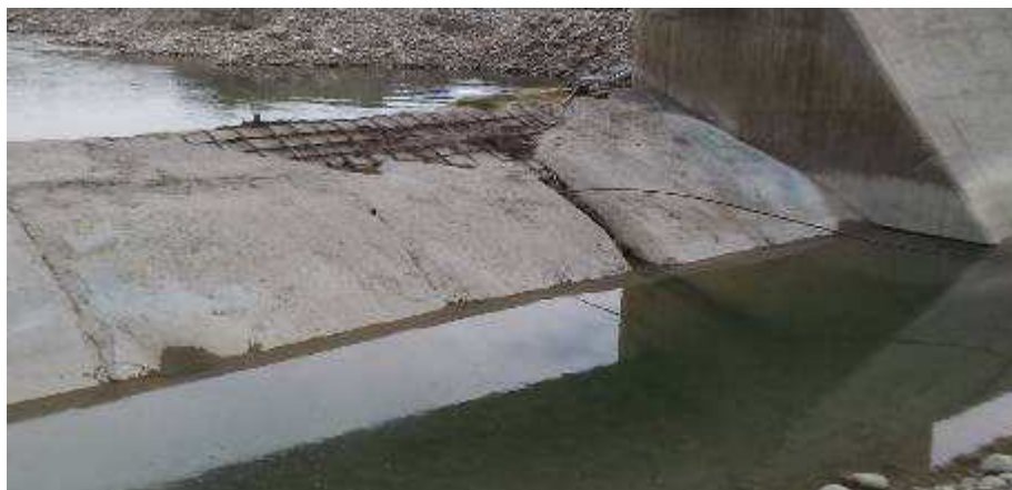
Foto 40. Prelievo ferri esposti. Manufatto limitatore di Monte
