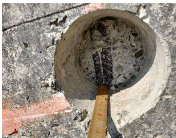
Fig.6.1 – Misurazioni dirette dei diametri e dei copriferri delle armature
