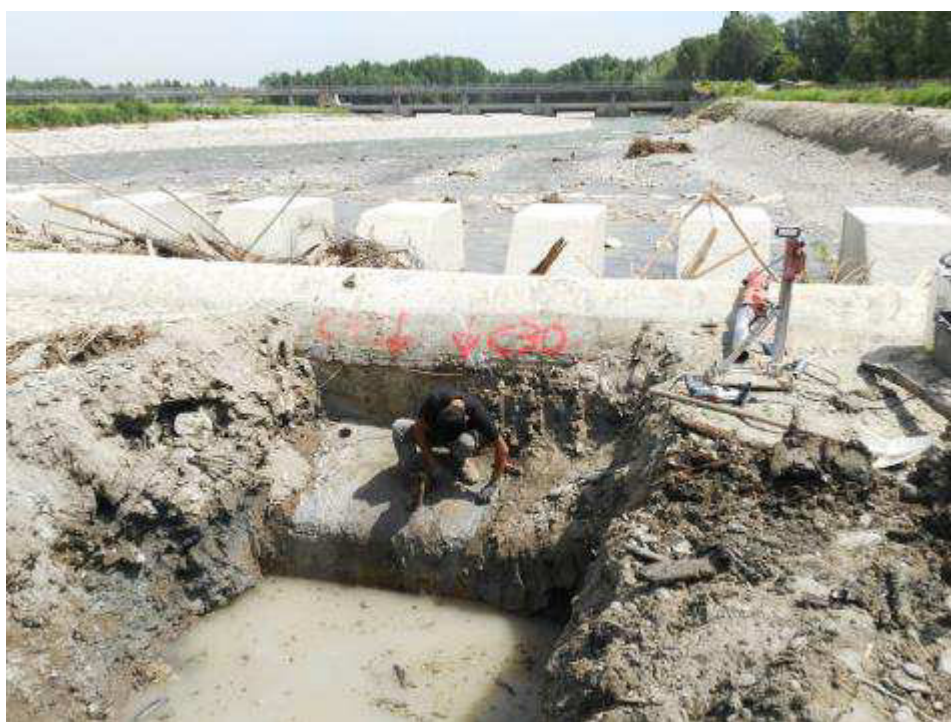
Foto 53. Traversa di Monte. Saggio in fondazione sponda destra
