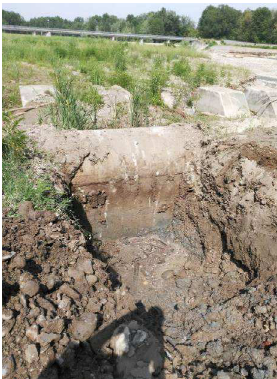
Foto 56. Traversa di Monte. Saggio in fondazione sponda sinistra
