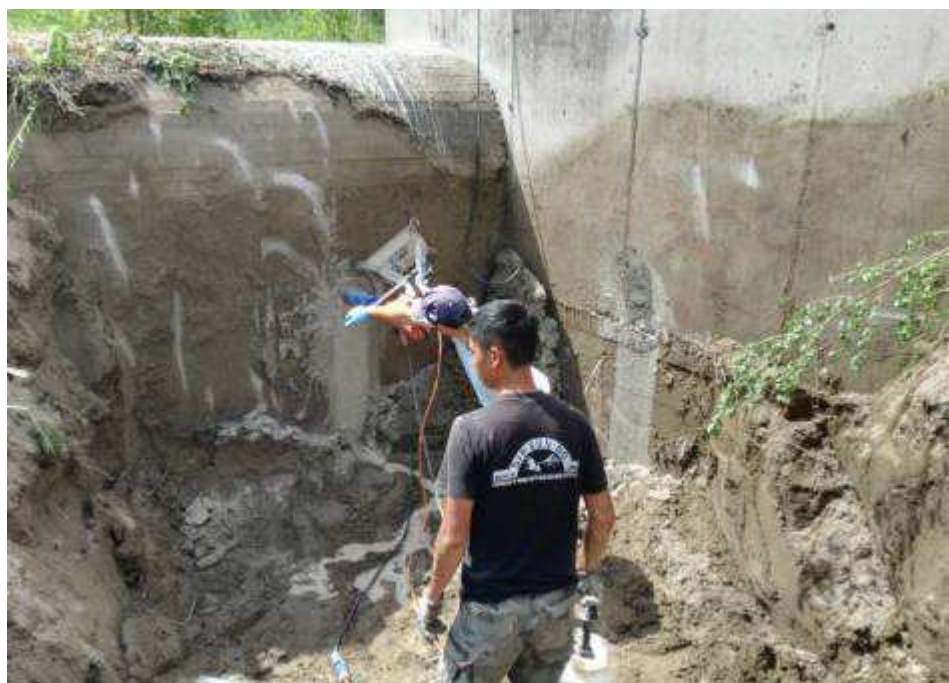
Foto 27. Manufatto limitatore di Monte. Sfioro troppo pieno. Esecuzione carotaggi in fondazione
