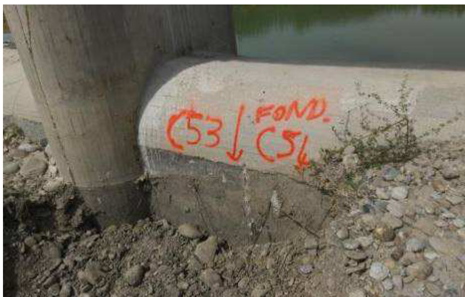
Foto 58. Manufatto limitatore di monte. Sfioro ingresso cassa. Saggio in fondazione
